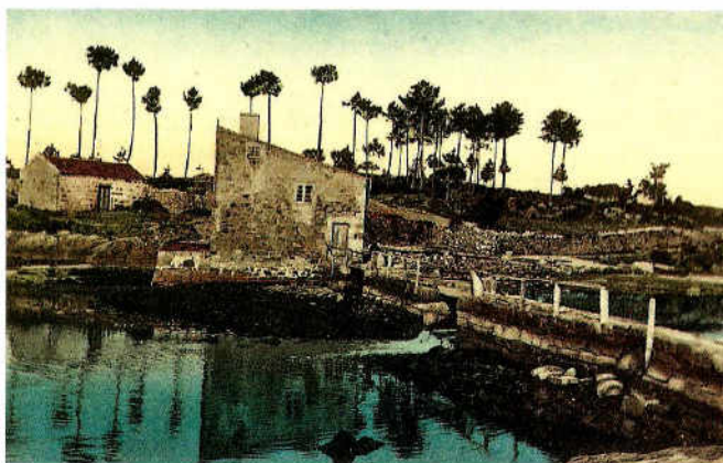
"Muro de contención do muíño de maré das Aceñas (A Illa de Arousa)."
